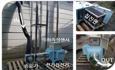
약취저감 집진장치의 구성 및 설치 모습
